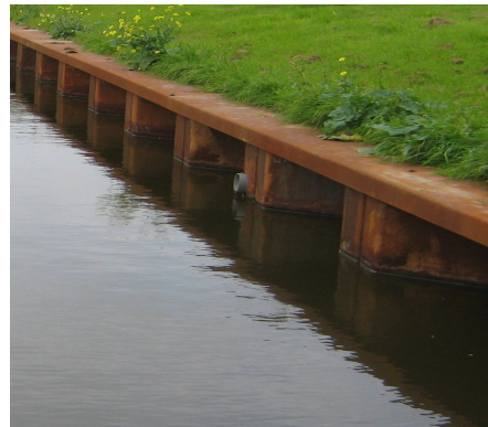
referentiebeeld 'stalen damwand met deksloof'
