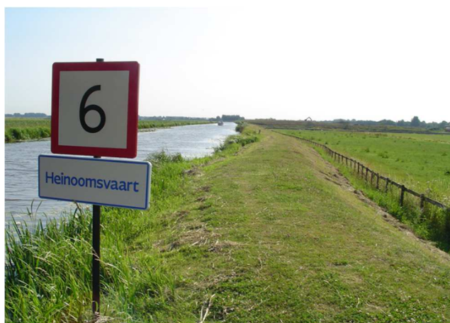
Figuur 3.2; Vak D en E, met op de achtergrond de hoge ligging ter plaatse van de voormalige vuilstort
