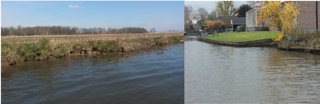
Figuur 6 Afkalving en te lage beschoeiing langs de Oude en Leidsche Rijn
