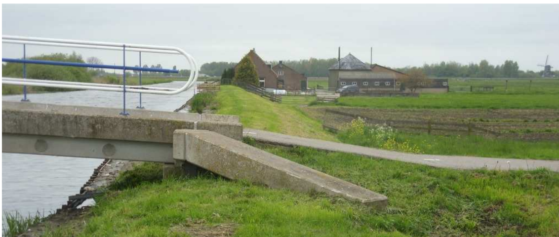
Afbeelding 2.3: Oostelijke boezemkade ter hoogte van de Boerderijweg
