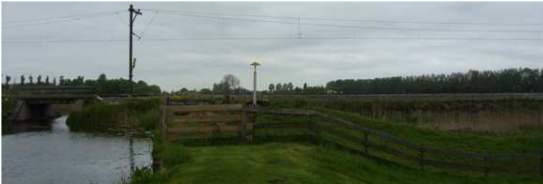
Afbeelding: zinker met 66 bar gasleiding ten zuiden van spoorlijn Bodegraven-Woerden
