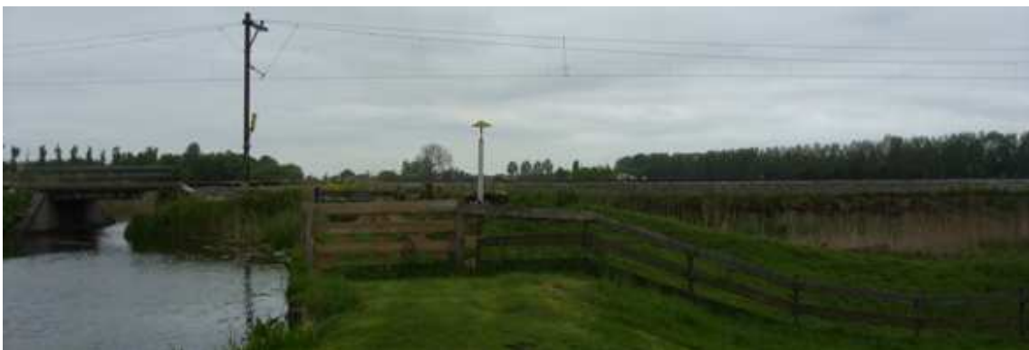
Afbeelding 2.4: zinker met 66 bar gasleiding ten zuiden van spoorlijn Bodegraven-Woerden
