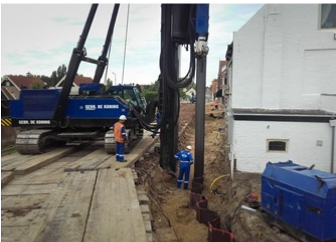
Figuur 4.2: Het aanbrengen van stalen damwanden middels een druktechniek
