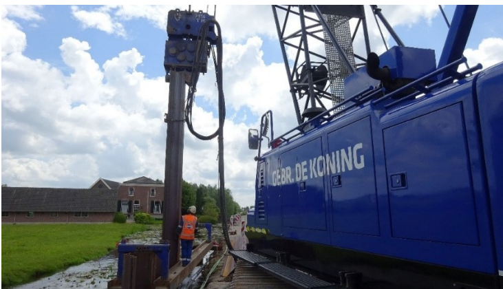
Figuur 4.1: Het aanbrengen van stalen damwanden middels een trilblok en draadkraan
