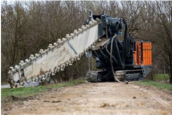
Figuur 4.5: Freesmachine t.b.v. aanbrengen Soilmix
