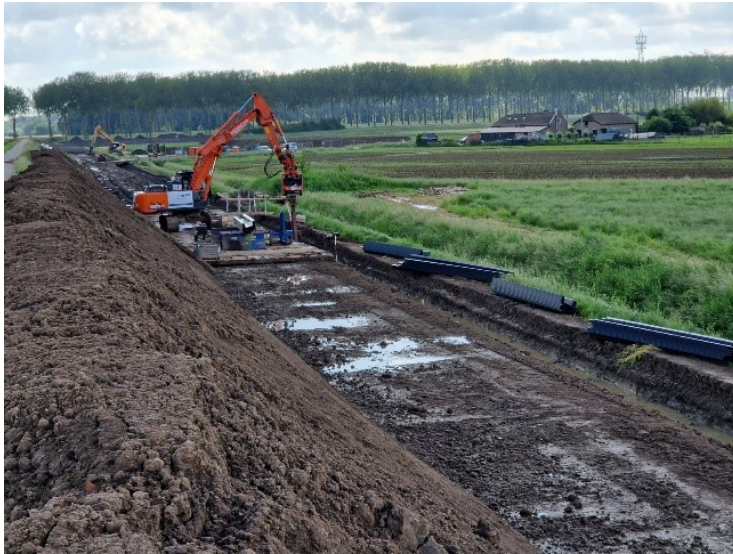
Figuur 4.4: Het aanbrengen van kunststof damwanden
