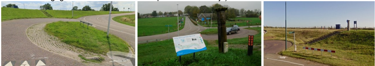
Figuur 11 - Huidige inrichting rond Dijkpaal de Heul: een keerlus die afbreuk doet aan de structuur van de dijk, een rommelige inrichting rond de dijkpaal en een versleten dijktrap.
