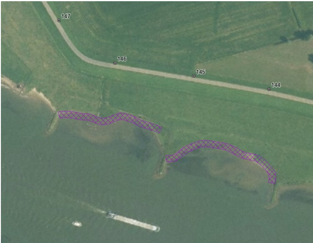
Figuur 4: Erosie oever kribvak tussen dijkpaal 144-147 met daarin de oeverbescherming ingetekend.
