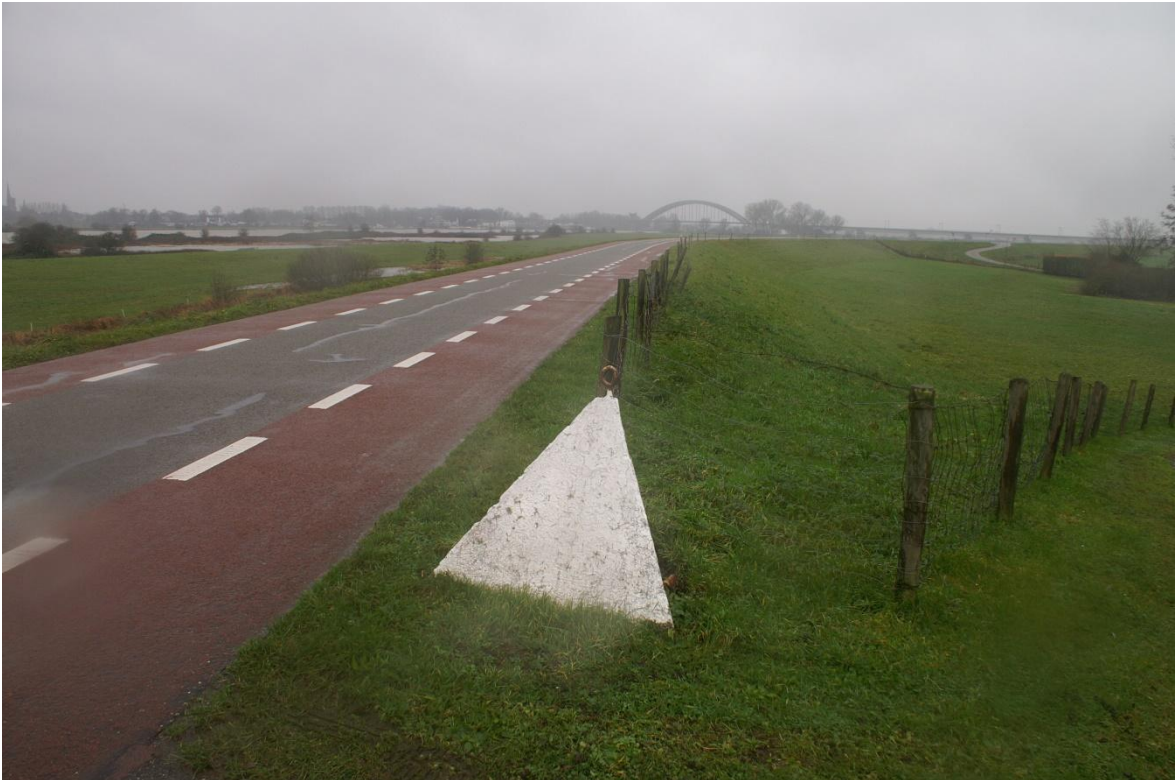
Afbeelding 14 Impressie van het plangebied met op de voorgrond de NHW Tetraëder, ter hoogte van de Lekdijk 10 te Schalkwijk (aan de oostzijde). Foto: Vestigia 19-12-2023.
