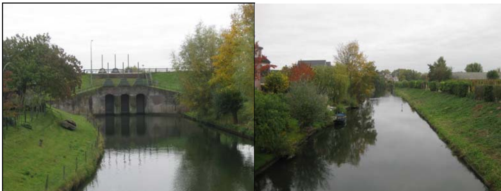
Fig.1.1. Links: Een dijk scheidt Kromme Rijn en Nederrijn bij Wijk bij Duurstede. Het inlaatwerk maakt het mogelijk om 4 tot 10 m 3 /sec rivierwater aan te voeren. Rechts: het water stroomt door een afwisselend open tot halfopen landschap.
