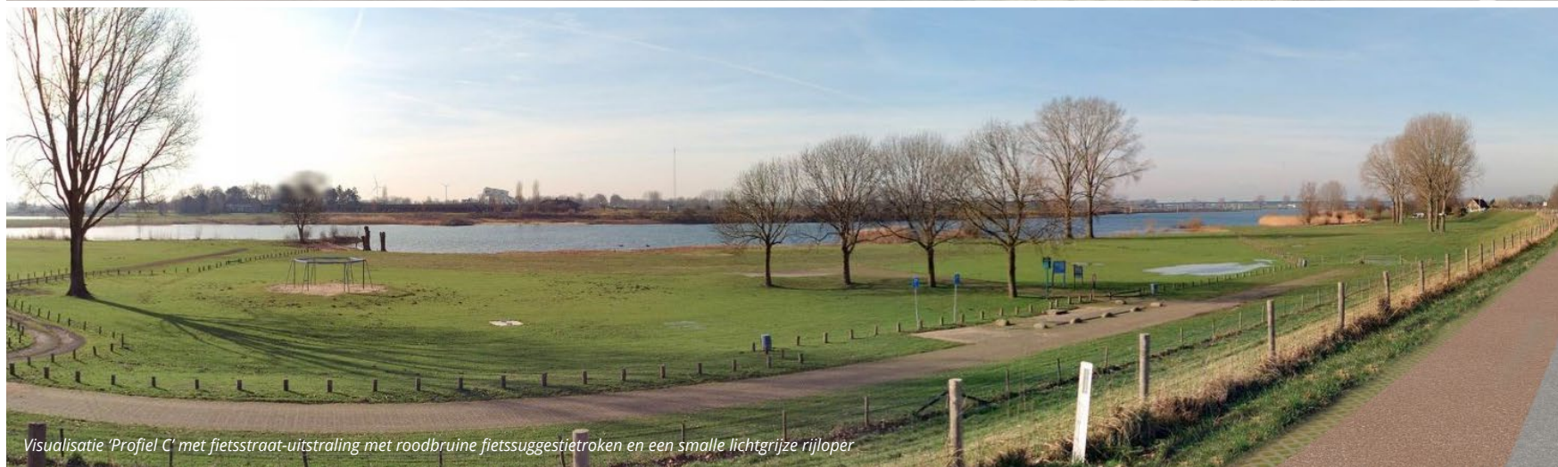
Visualisatie 'Profiel B' met fietssuggestiestroken van 1,20-1,30m breed, hier weergegeven op een dijktracé met smalle kruin nabij Lopik
