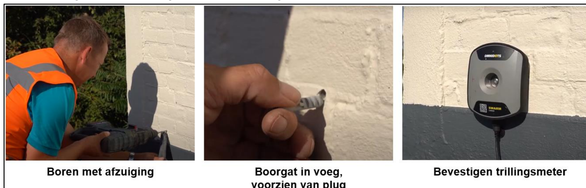
Figuur 12, Aanbrengen van trillingsmeter in gevel woning.
