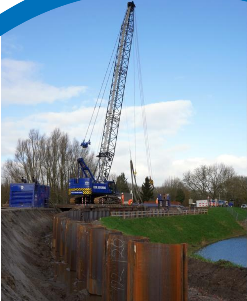
Aanbrengen damwanden
