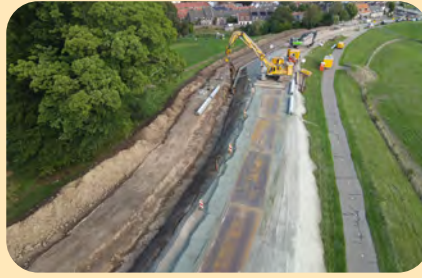
Afbeelding 7: Werkvak Kasteel tijdens werkzaamheden in september 2025.
