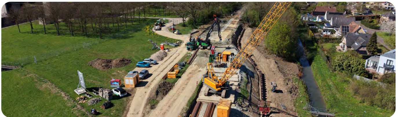
Afbeelding 9: Binnendijkse damwandwerkzaamheden in werkvak Kanaaldijk.
