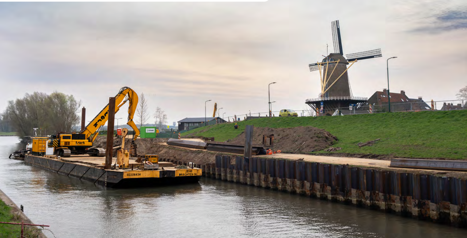
Afbeelding 6: Werkzaamheden vanaf het water in werkvak Waterfront.
