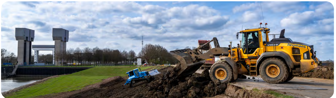
Afbeelding 10: Buitendijks grondwerk in werkvak Kanaaldijk.
