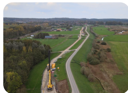
De drie damwandstellingen langs de dijk bij Amerongen in oktober
