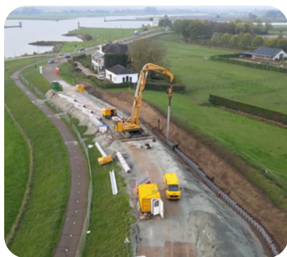
De laatste damwanden worden aangebracht langs Lekdijk Oost in oktober
