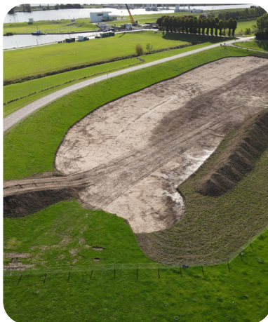
De steunberm nabij Sluis Amerongen
