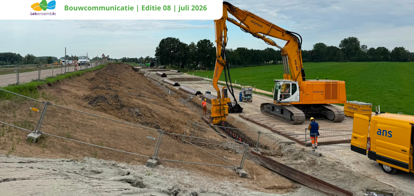
Afbeelding 4: Damwandwerkzaamheden in dijkvak Lunenburgerwaard Oost
