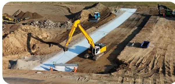
Afbeelding 6: Uitgerolde bentonietmat in de Lunenburgerwaard
