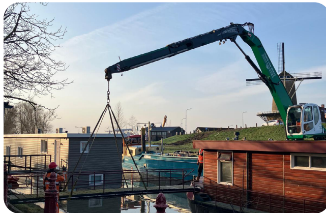
Afbeelding 3: Afkoppelen van de aansluitingen van de woonboten in het Inundatiekanaal zodat deze verplaatst konden worden.
