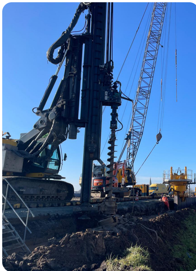
Afbeelding 1: de machines die nodig zijn voor het plaatsen van damwanden nemen veel ruimte in op de weg.
