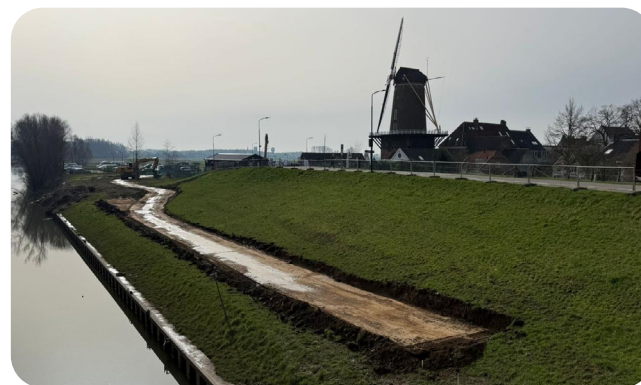
Afbeelding 6: Het werkkerrein langs het Inundatiekanaal is ingericht.
