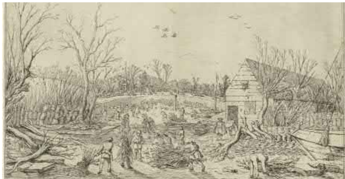
Herstelwerkzaamheden aan de doorgebroken Lekdijk, Esaias van de Velde, 1624 - 1652
