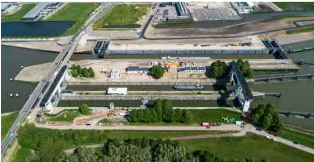
Industriële stenen dijk bij de Beatrixsluizen
