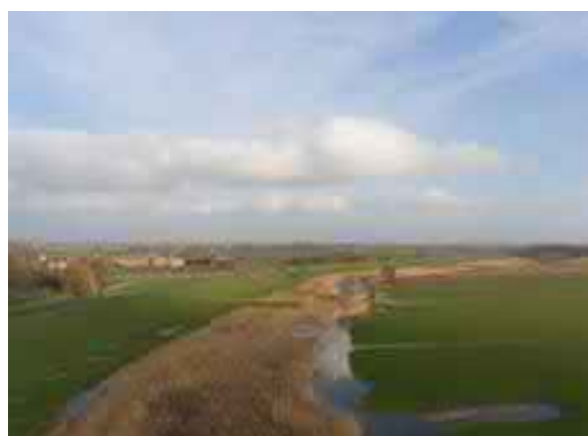
Kleiputten tussen dijk en oudhoevig land
