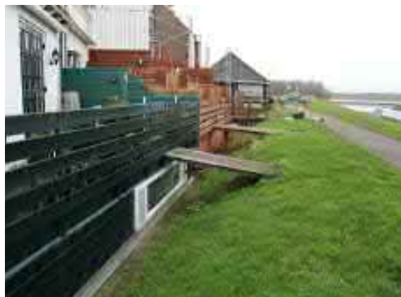
Woningen direct aan de dijk
