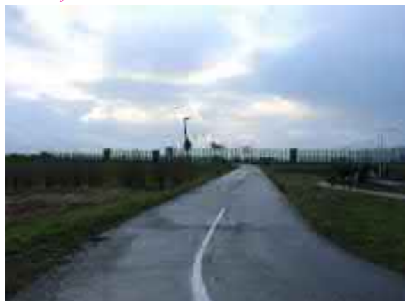
De hoofdroute van de fiets loopt richting de brug, in plaats van de tunnel. De tunnel zelf is nu onnodig lang door het gedeelte onder de oude brug.
