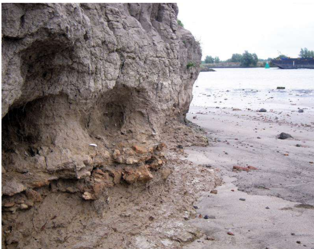
Figuur 28: Laag met bakstenen en baksteenpuin aangetroffen aan de noordoever van de Lek (bron: Smit 2010).
