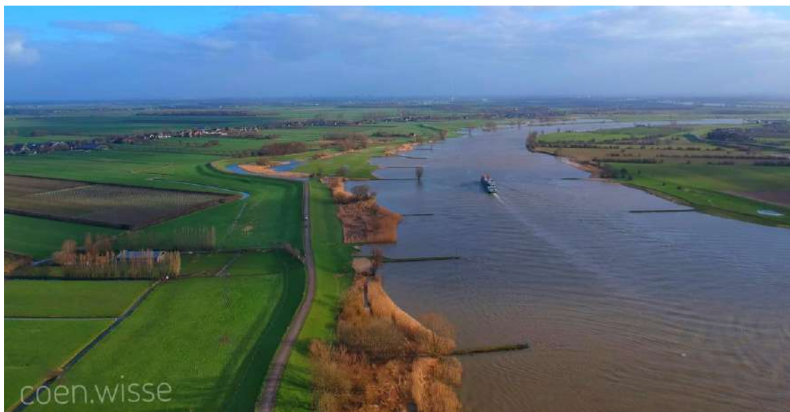
Figuur 3-3 Dronebeeld van het weidse deel van de dijk (C. Wisse)
