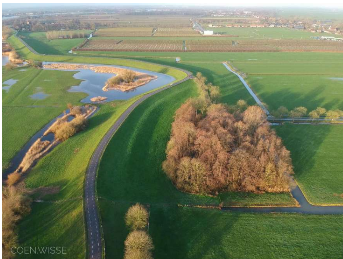
Figuur 3-2 Dronebeeld waarin het kenmerkende profiel van de dijk goed te zien is (C. Wisse)
