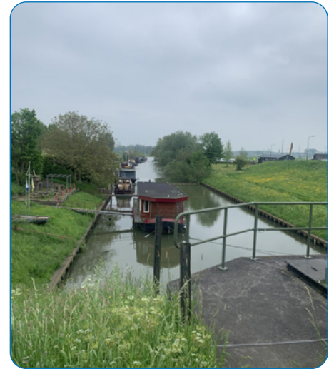
Inundatiekanaal gezien vanaf de Inlaatsluis
