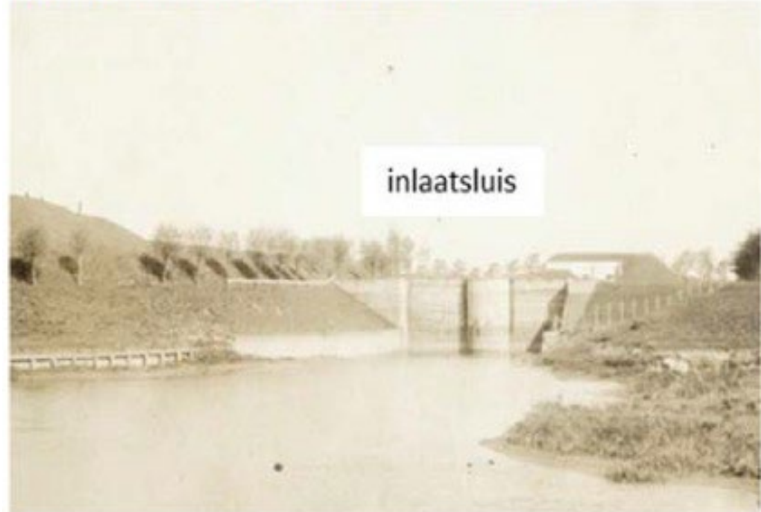
Inlaatsluis aan de Lekzijde
