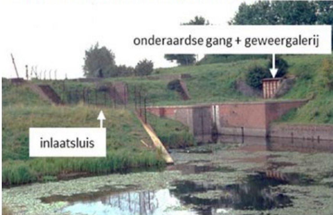
inlaatsluis aan binnenzijde van de dijk met de poterne
