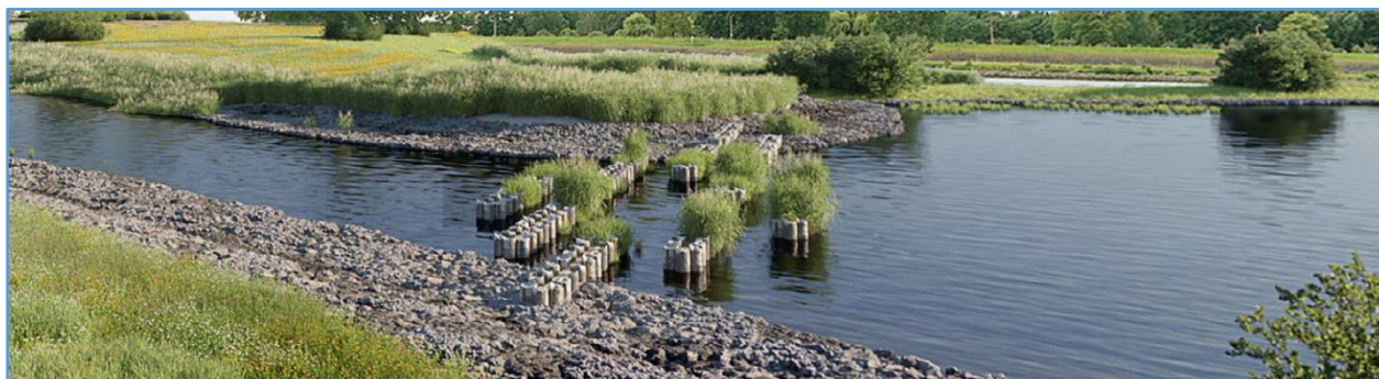
Figuur 5-7 De variant "Natuurlijk" bevat een halfopen verbinding met houten schotten bij de geulmonding [5]
