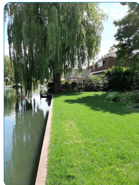
Het eindresultaat na de werkzaamheden
