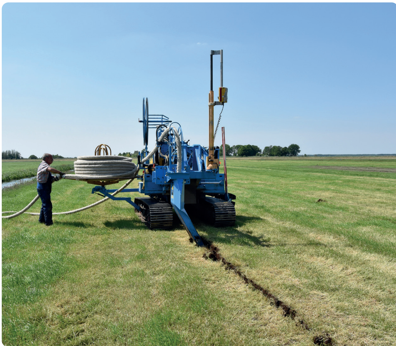
Figuur 3 Aanleg waterinfiltratiesysteem
