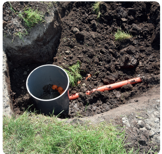
Figuur 9 Ondergrondse verzamelput
