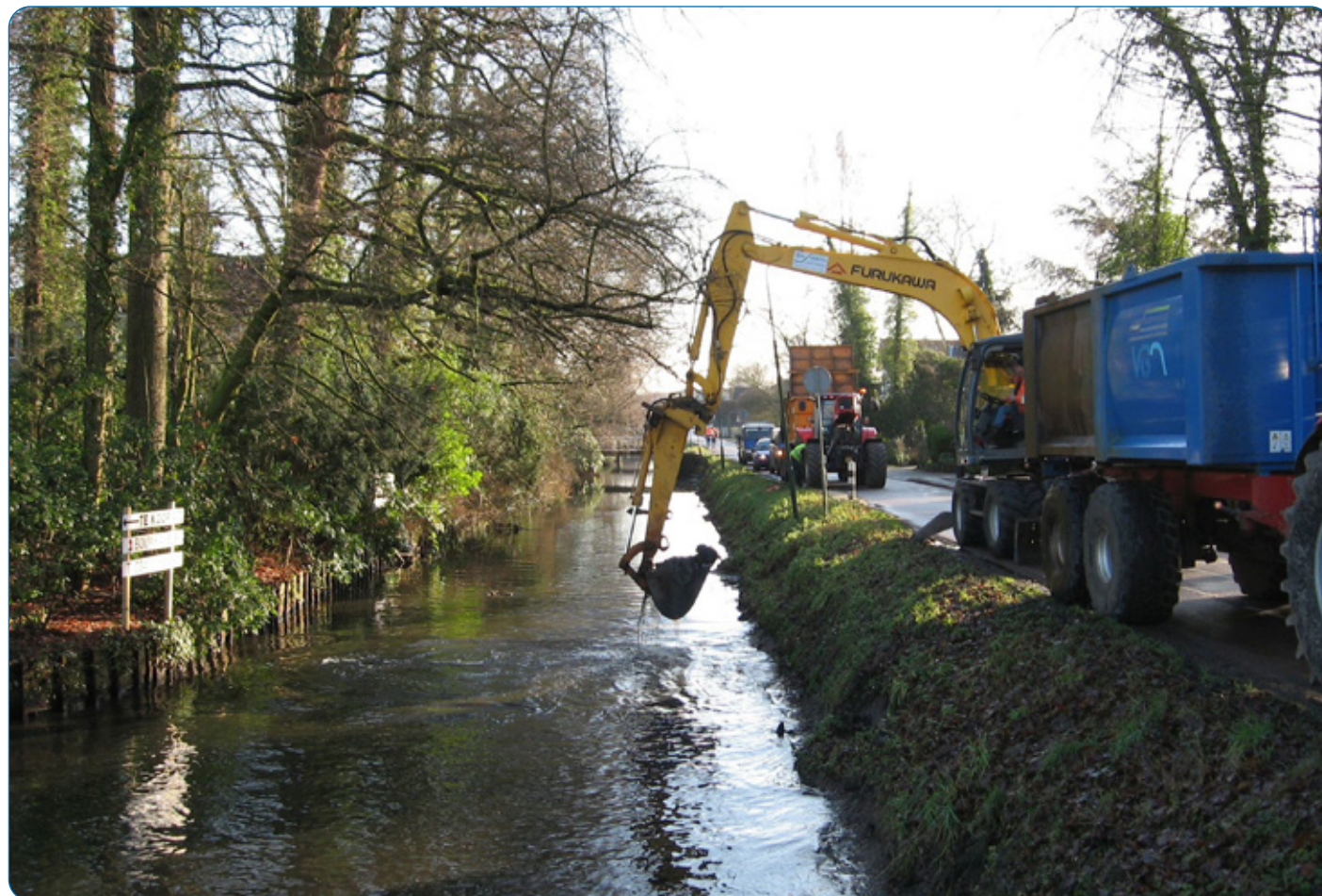
Baggeren met een kraan.
