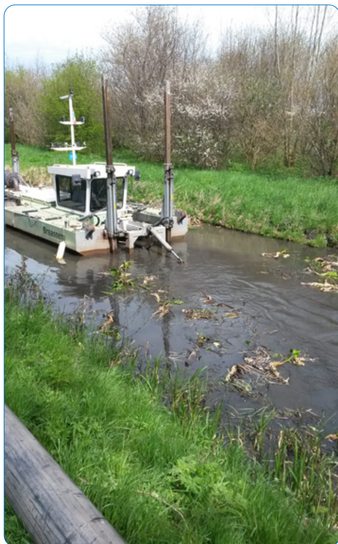
Baggeren met cutterzuiger.
