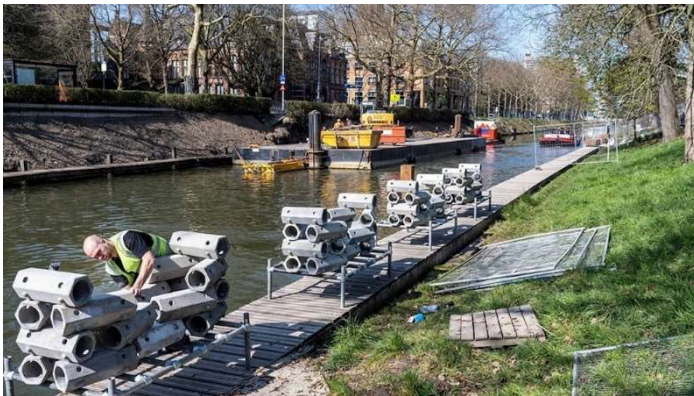
Foto 2: Aanleg van het onderwater rif in de Catharijnesingel (foto: CU2030/Gerrit Serné)
