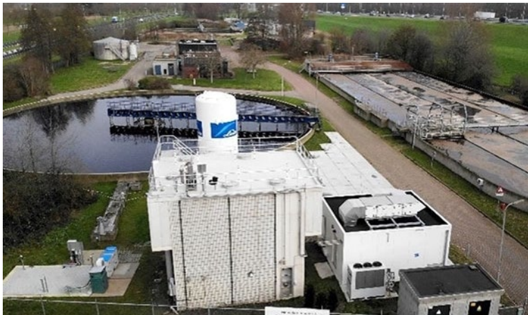
Figuur 2: Medicijnrestenverwijdering op RWZI Houten
