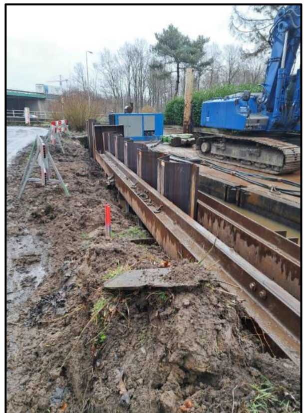
Figuur 18: foto van dijkverbetering project Korenmolenvliet-Dwarsdamweg
