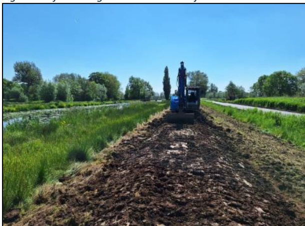
Figuur 17: foto van dijkverbetering project Korte Linschoten
