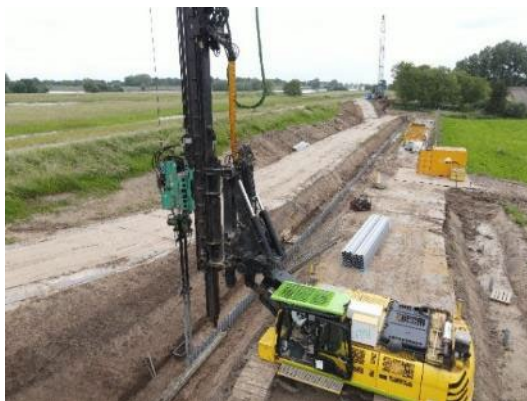
Figuur 15: aanbrengen Prolock filterscherm bij Salmsteke
