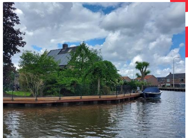
Figuur 8 kadeverbetering Kromme Mijdrecht en Kollensloot afgerond
