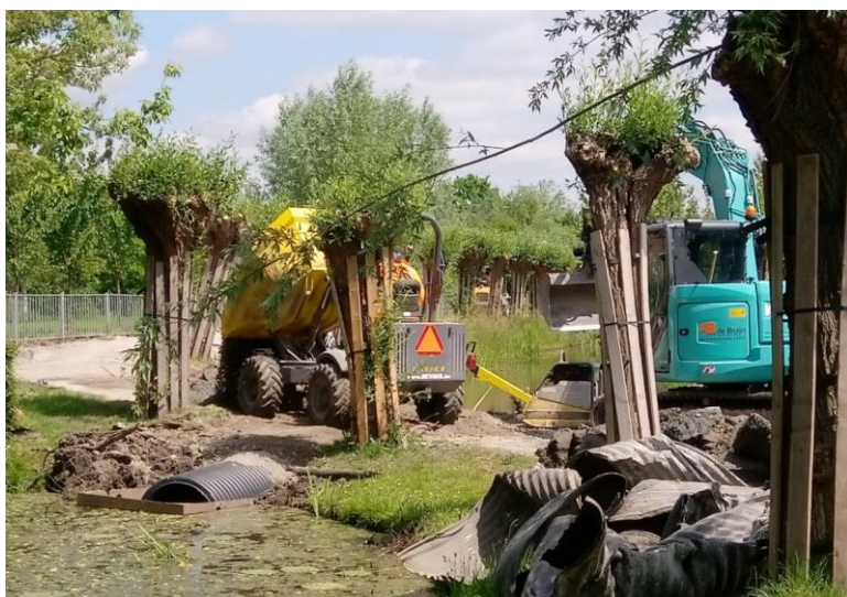
Figuur 20 foto van aanleg nieuwe duiker Vogelzangsekade te Lopik, een maatregel gefinancierd vanuit de Impulsregeling
