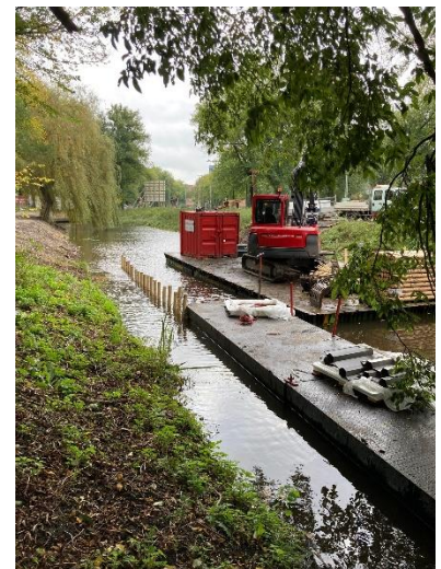
2021: Uitvoering project in Utrecht (NPD strook).
