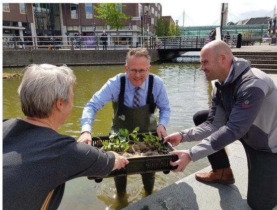
Aanleg drijvend groen in Houten, mei 2019
