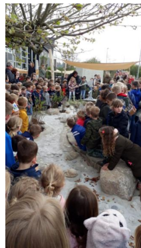
Aanleg van een wadi op het schoolplein van De Delteykschool in Werkhoven
