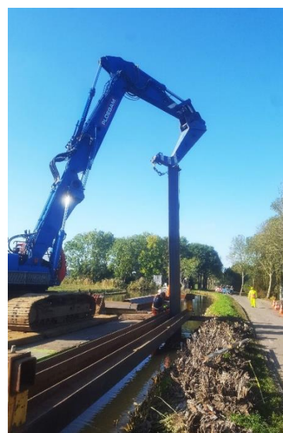
Kadeverbetering Montfoortsevaartkade oost
