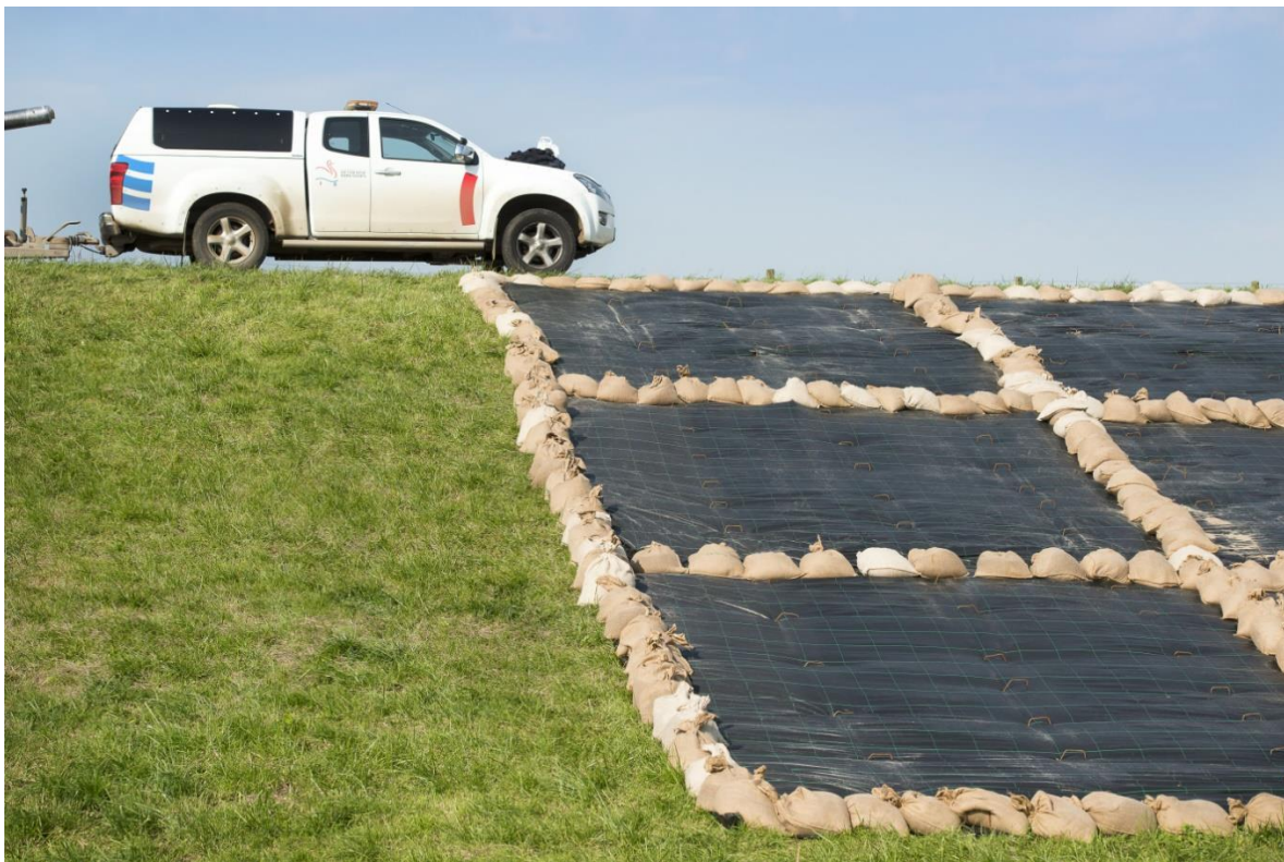
Foto: Oefening calamiteitenzorg, inpakken van een dijk
