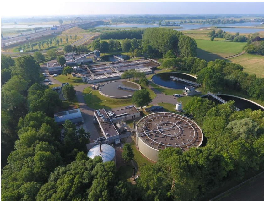
Foto: RWZI Nieuwegein
