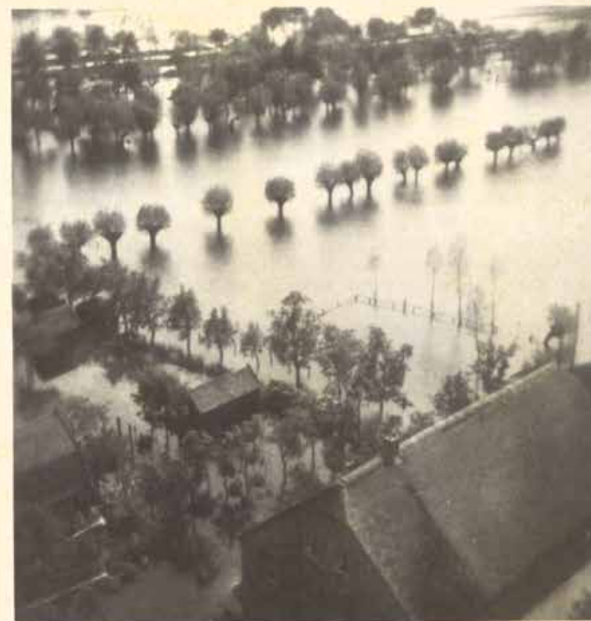
afb. 157 In 1945 stelde de Duitse bezetter inundaties om de opmars van de geallieerde legers te vertragen. Ondanks sabotage van de kant van de plaatselijke bevolking liep een groot gedeelte van Houten en Schalkwijk onder water. De foto toont de geïnundeerde polder Blokhoven. Collectie P. M. Heijmink Liesert.
