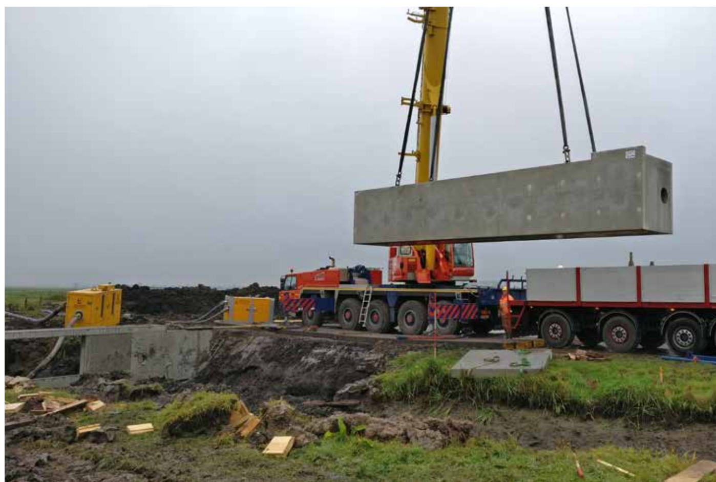
De betonnen vispassage wordt op z'n plek gehesen. Links op de foto is de stuw in aanbouw.
