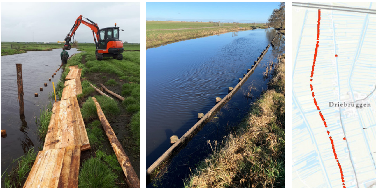
Figuur 3: Aanleg en locatie onderwaterbeschoeiing.
