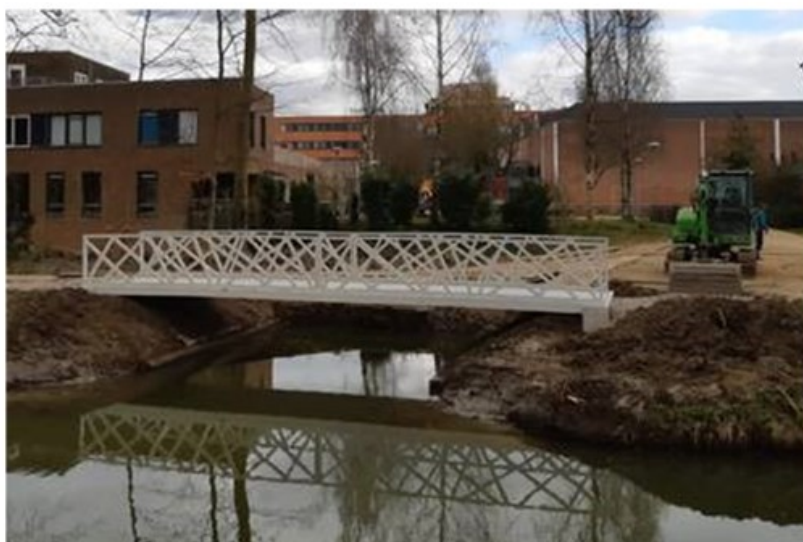
Opgewaardeerde nevengeul met nieuwe brug
