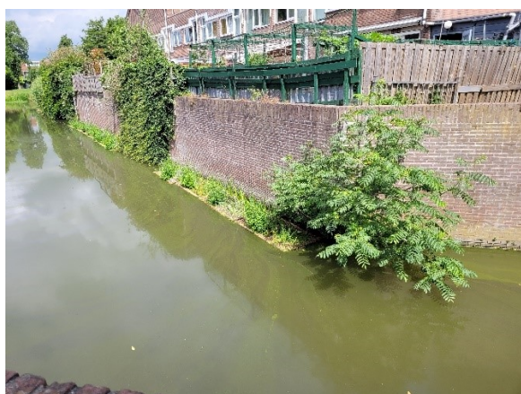
Resultaat na aanleg.
