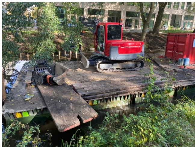
Aanleg in volle gang met drijvende pontons.
