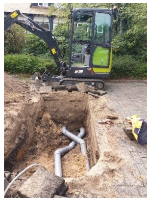
Wisselen aansluitingen huizen
