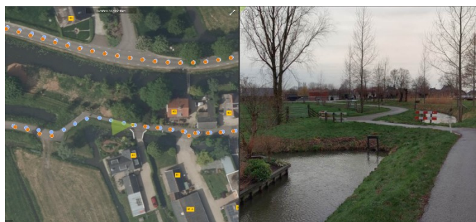
Aanleg duiker Wielsekade
