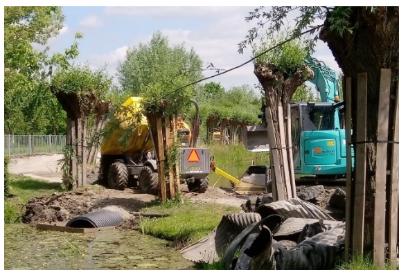
Aanleg duiker Vogelenzangkade
