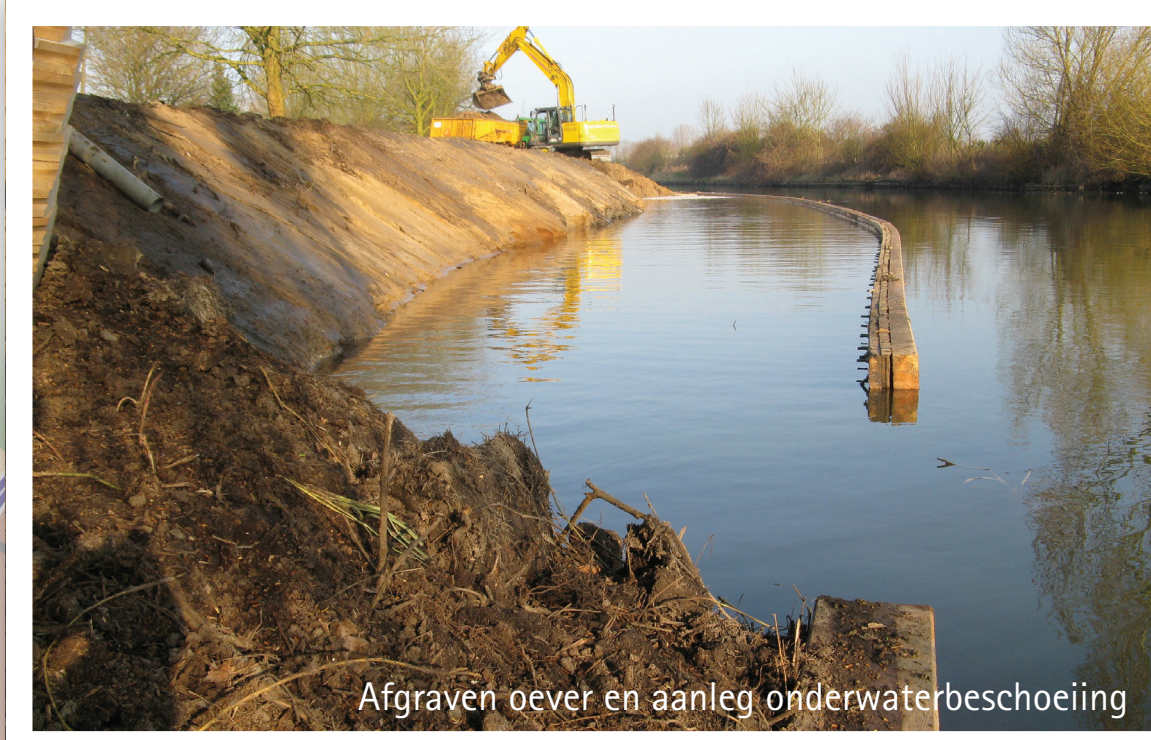
Afgraven oever en aanleg onderwaterbeschoeiing
