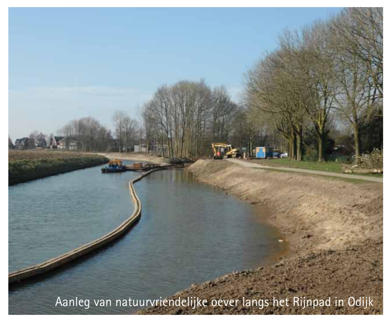
Aanleg van natuurvriendelijke oever langs het Rijnpad in Odijk
