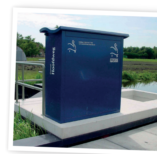
Bij veel stuwen, inlaten en kleine gemalen staan deze blauwe bedieningskastjes met 'golfdak'.
