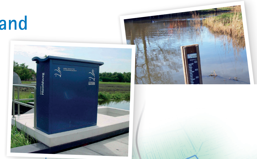
Bij veel stuwen, inlaten en kleine gemalen staan deze blauwe bedieningskastjes met 'golfdak'.
