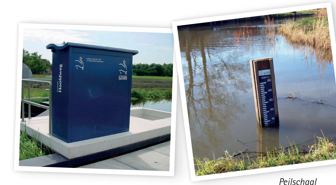
Bij veel stuwen, inlaten en kleine gemalen staan deze blauwe bedieningskastjes met 'golfdak'.
