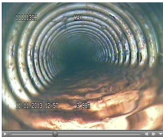
Figuur 5 Goede ontwatering door drain, geïnstalleerd in Texelse zeeklei (foto: L C P M Stuyt, 11 november 2013)
