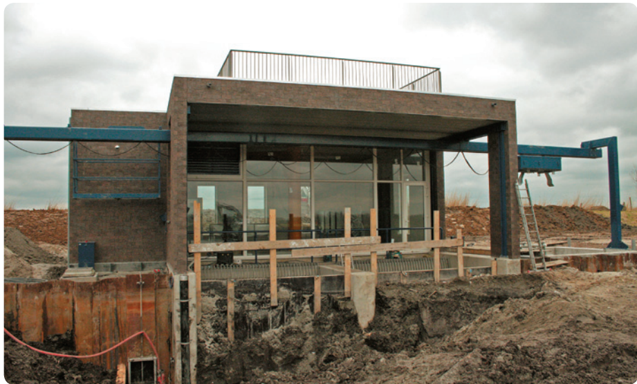
De bouw van het nieuwe gemaal vordert gestaag
