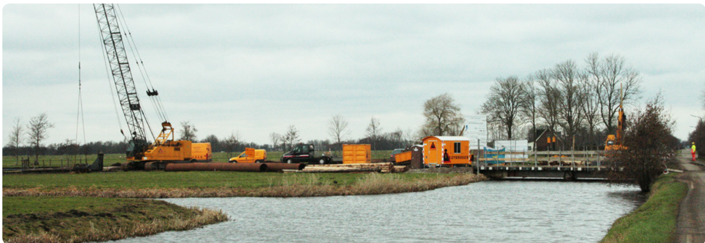
De werkzaamheden ter hoogte van de kruising nieuwe maalvliet / Kamerikse wetering
