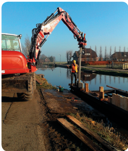
De damwand is nodig voor een bak onder water. Deze bak voorkomt dat de nieuw aangelegde duiker (onder de weg) volstroomt met bagger.
