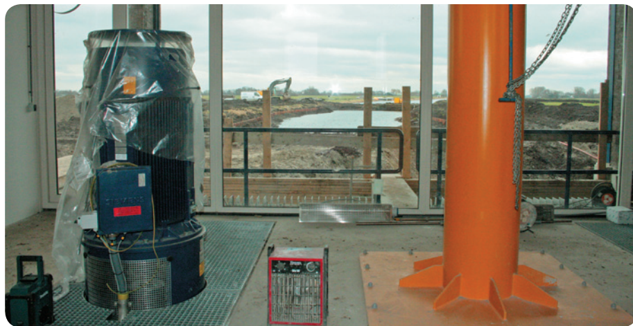
Zicht op de nieuwe maalvliet gezien vanuit gemaal Oud-Kamerik.
