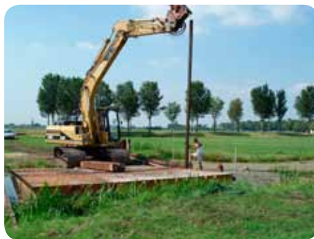
Plaatsen damwand langs de Ir. Enschedeweg
