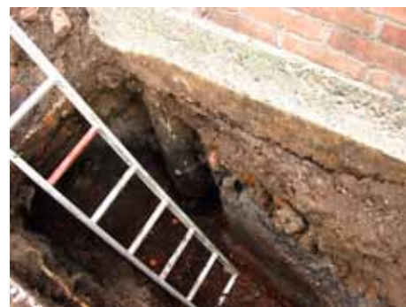
Vrijgegraven fundering bij een bebouwingsonderzoek
