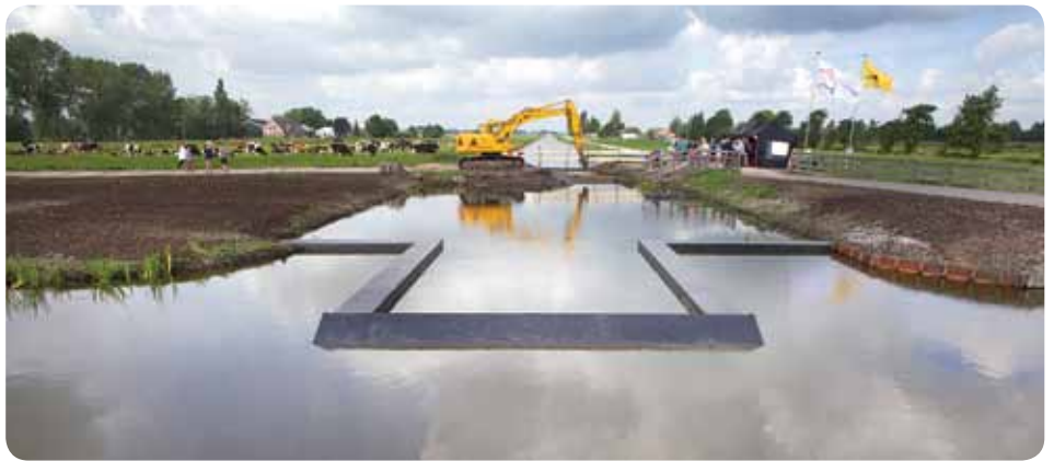
Het nieuwe aquaduct is op 28 juni 2014 geopend
