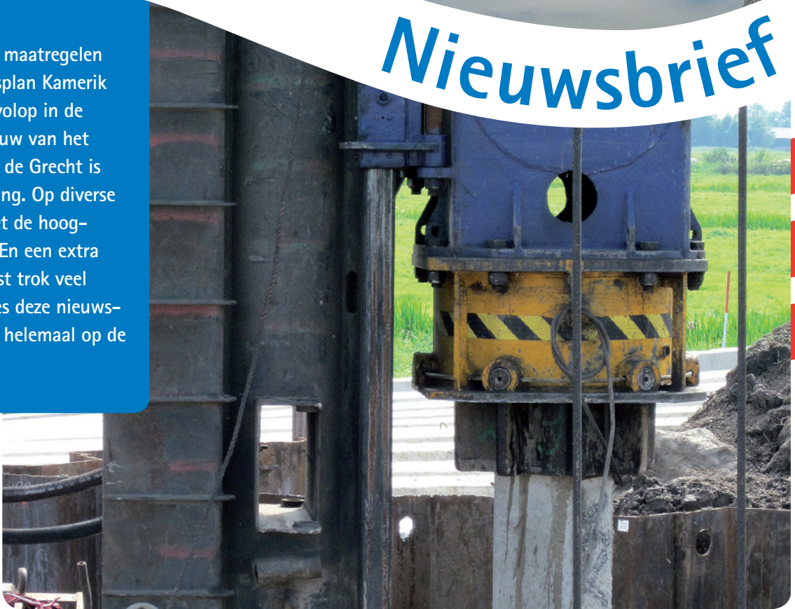
De bouw van gemaal Oud-Kamerik vordert gestaag
