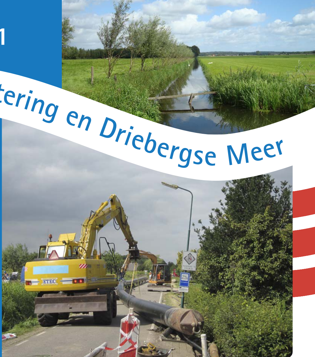
Aanbrengen duiker onder Doornseweg (N227)
