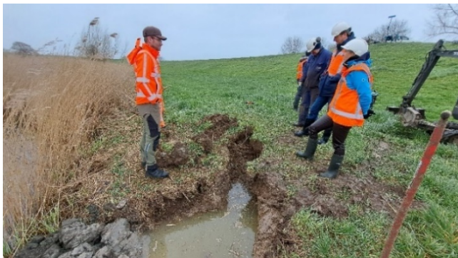
Afbeelding 6: uitgegraven beverhol primaire waterkering HDSR 2023
