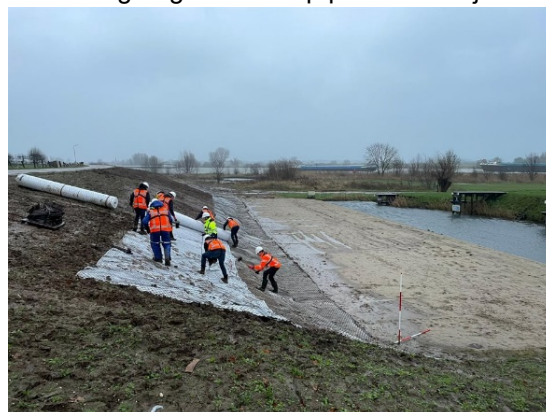
Afbeelding 1: 'Inpakken' van versterkte dijk bij Salmsteke
