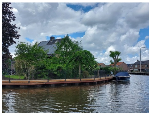
Afbeelding 5: kadeverbetering Kromme Mijdrecht en Kollensloot afgerond
