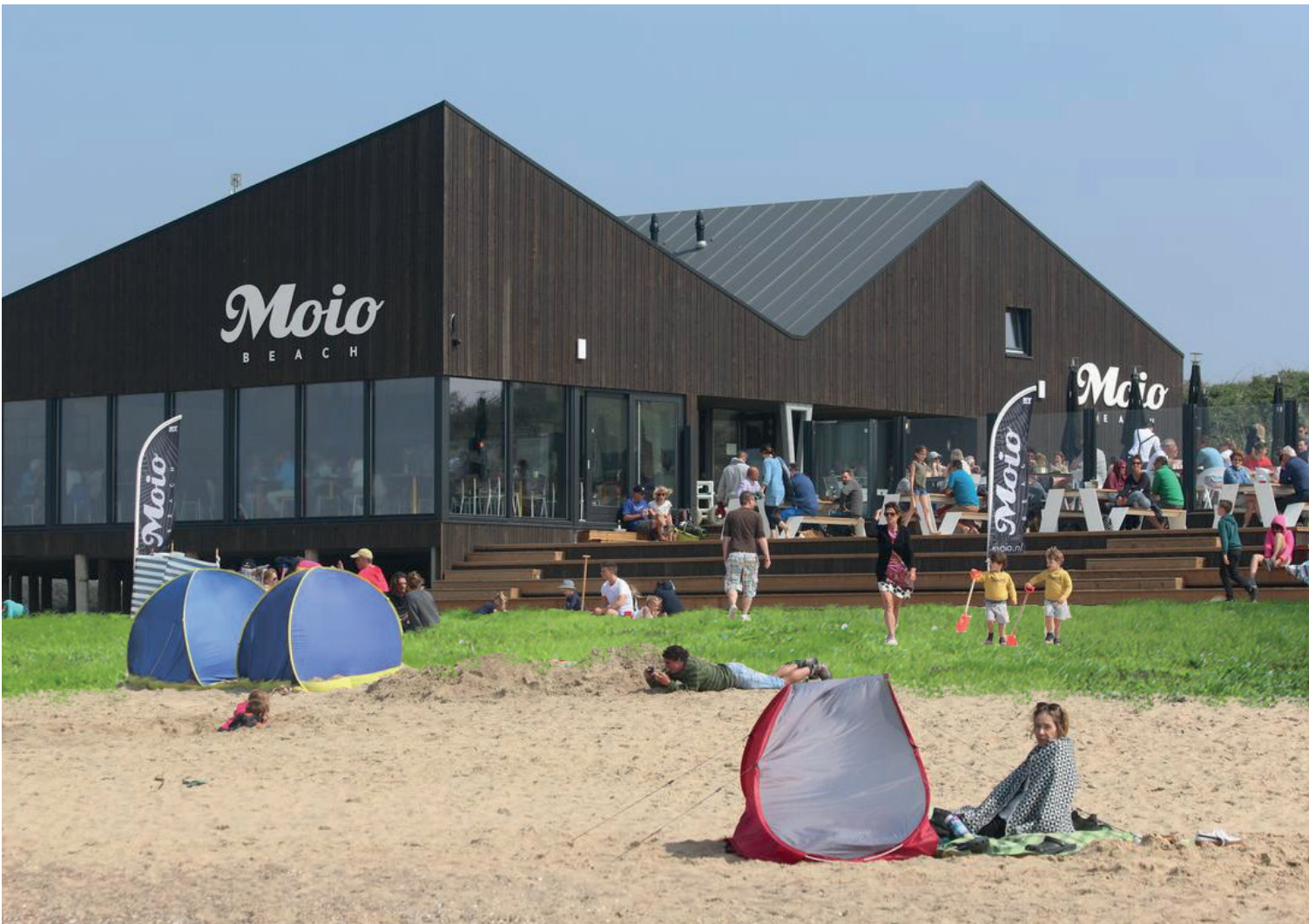
Het paviljoen wordt omgeven door een terras, met flauwe trap-treden naar het maaiveld waarop gezeten kan worden.
