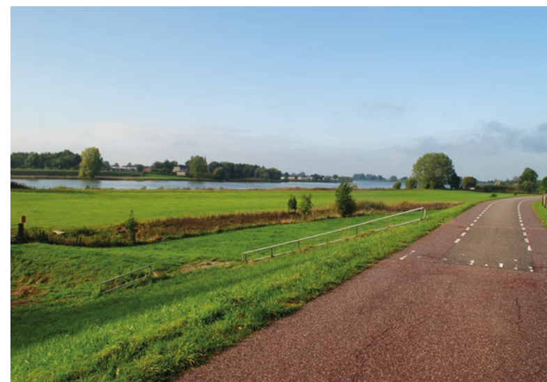
afbeelding 2: Bestaande dijkovergang waar een kans ligt voor het creëren van veilige kruisingen bij wandelroutes
