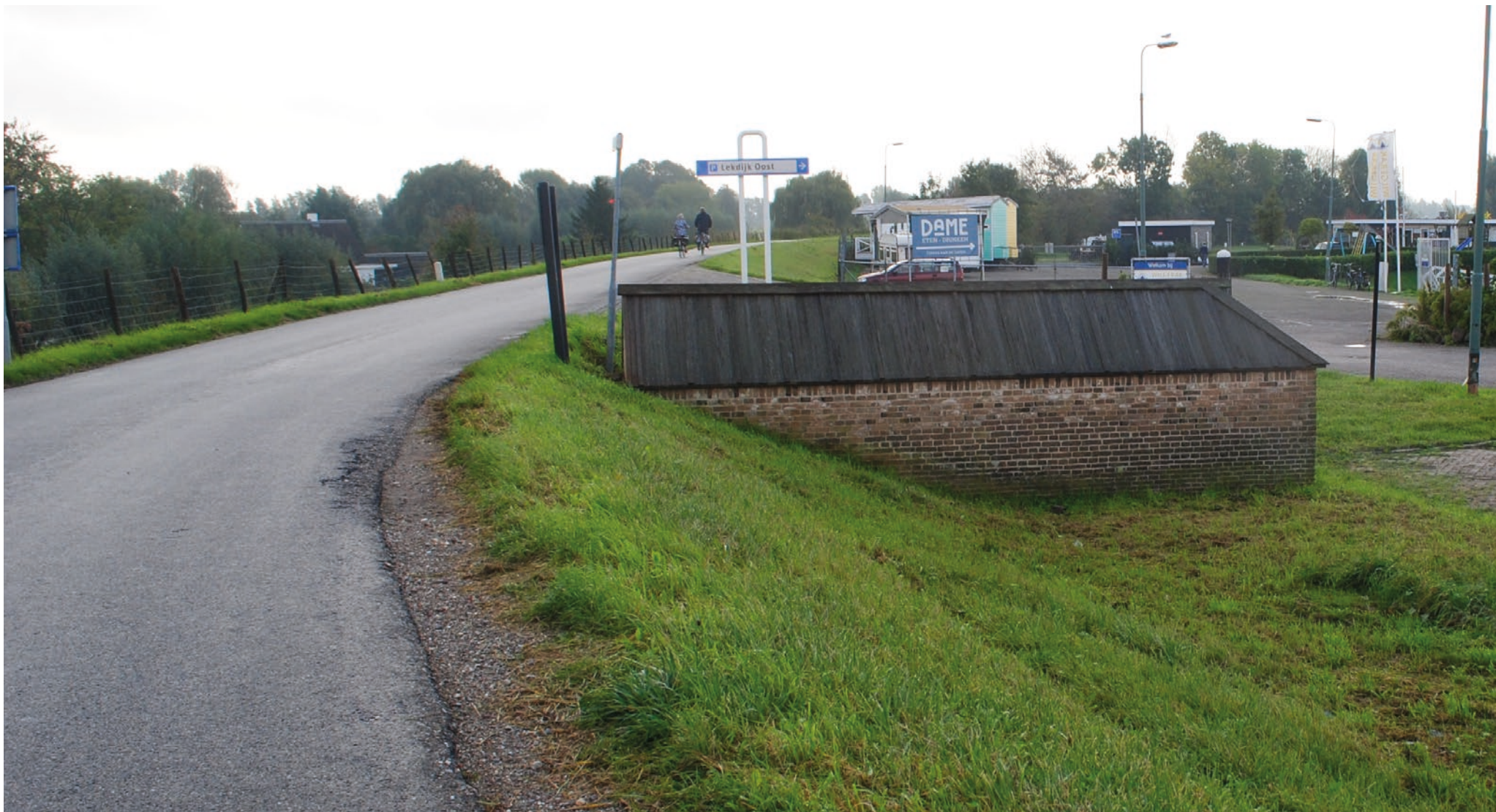
afbeelding 19: Bestaand peilschaalhuisje langs de Lekdijk
