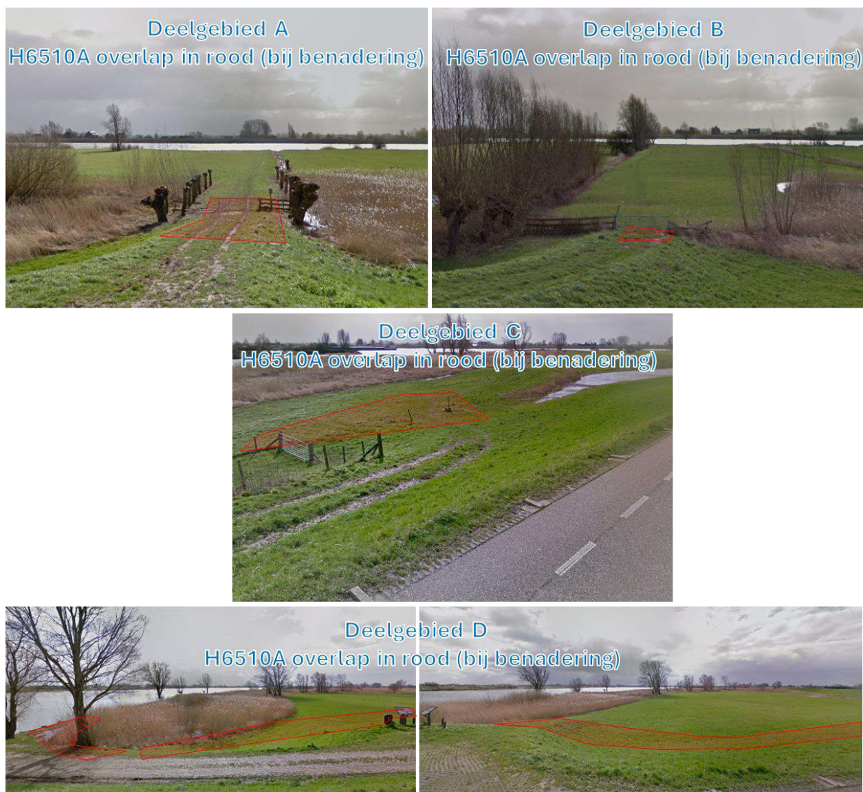
Figuur 5-6 Foto's van de locaties van H6510A (deelgebieden A t/m D zoals in Figuur 5-2 t/m Figuur 5-5) waar sprake is van ruimtebeslag (bij benadering aangegeven in rood) door de taludverflauwing, de beheerstrook en de tijdelijke werkstrook.
