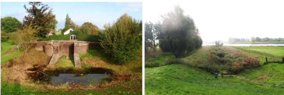
Figuur 17 Links: heul bij het voormalig stoomgemaal Wiel en Vogelzang en rechts uitwateringskanaal (voorboezem) bij de heul, beide gemeentelijk monument.
